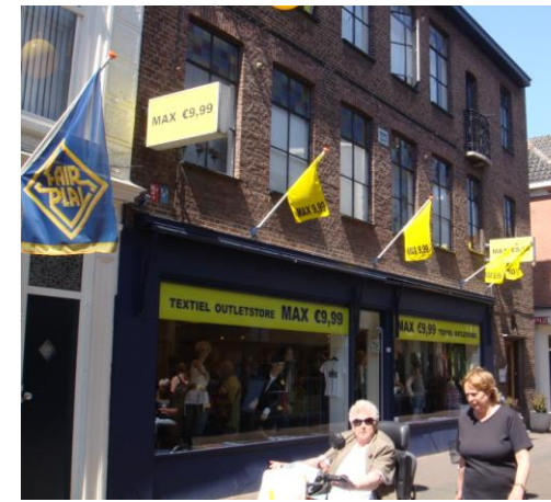
Hoogstraat 125 Foute reclame. Vlaggen verstoren het gevelbeeld. Een uithangbord zit te hoog. Reclame bestrijkt de hele breedte van het pand
