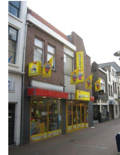
Hoogstraat 172-174, Foute reclame. Vlaggen verstoren het gevelbeeld. De uithangborden zitten te hoog. De lichtbakken zijn te groot.
